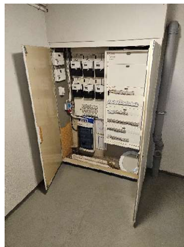
Figur 3. Exempel på elmätare till lägenheterna på bottenplan GG33 och i källare GG37.
